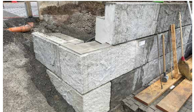
Bild 24 Versetzen der Eckelemente
