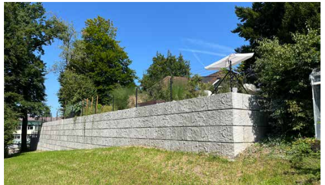
Bild 26 Geländer auf Mauerkrone
