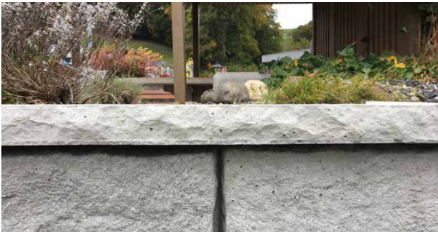
Bild 25 Abdeckplatten versetzt
