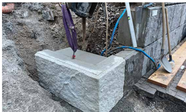
Bild 22 Anfangssteine mit Streifenfundament ohne Klebemörtel
