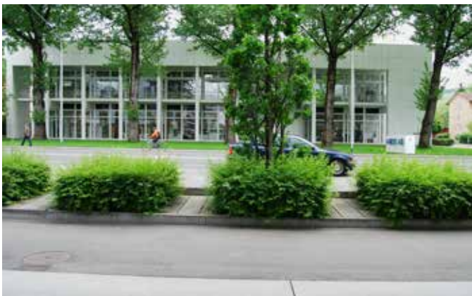
Einbau von Verbindungen zwischen den Baumgruben
