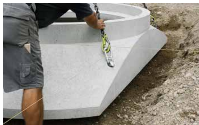
Versetzen des Basiselementes
