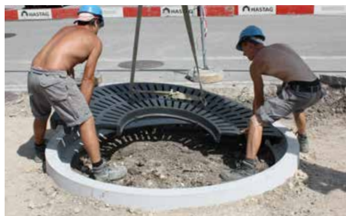
Versetzen der Gussroste
