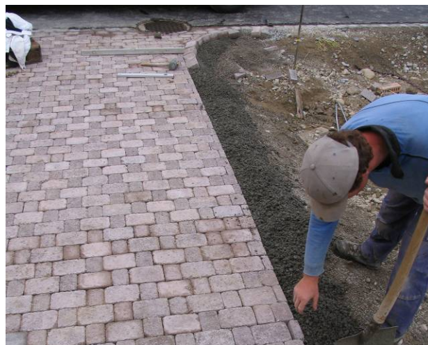
Bild 43: Erstellen des Randabschlusses
