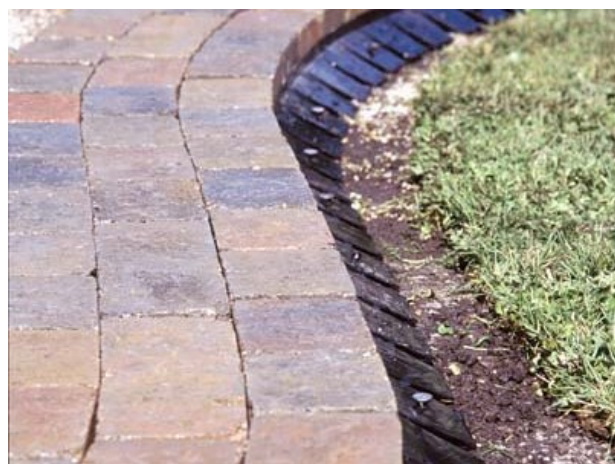
Bild 44: Randabschluss mit PAVE EDGE Randschienen
