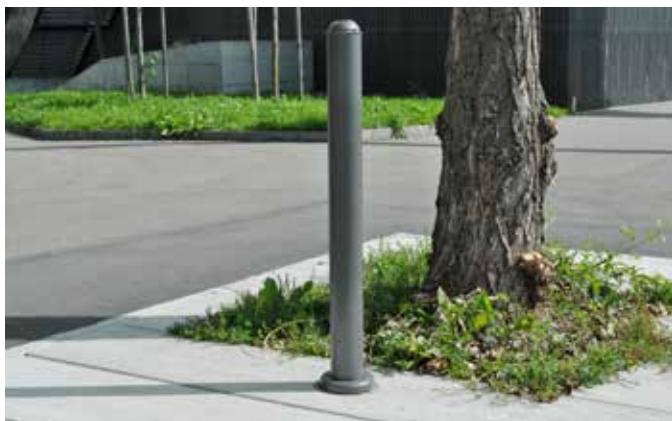
Stammschutzpfahl für sämtliche Betonabdeckungen
