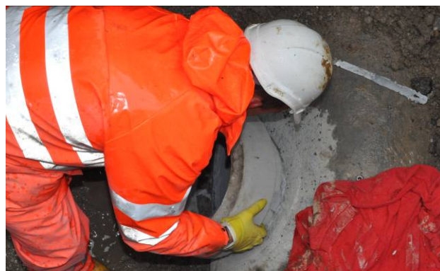
Bild 11: Klebeanschlussstück mit einer Drehbewegung einsetzen
