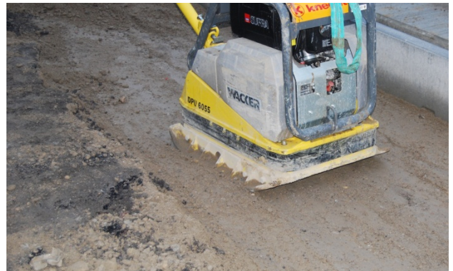
Bild 35: Verdichten nur mit leichten Verdichtungsgeräten
