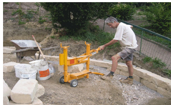
Bild 35: Arbeiten mit Steinspalter
