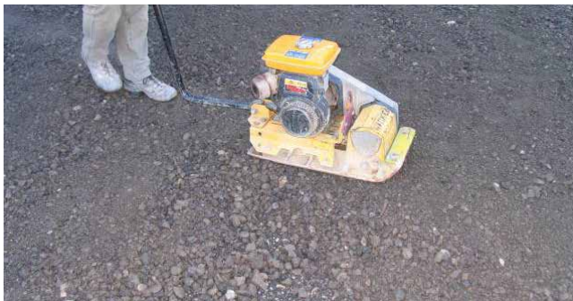
Verdichten der Fundationsschicht
