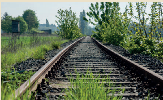
Bahngleis mit Bewuchs
