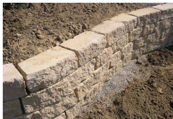
Bild 28: Kurvenbildung mit geraden Steinen
