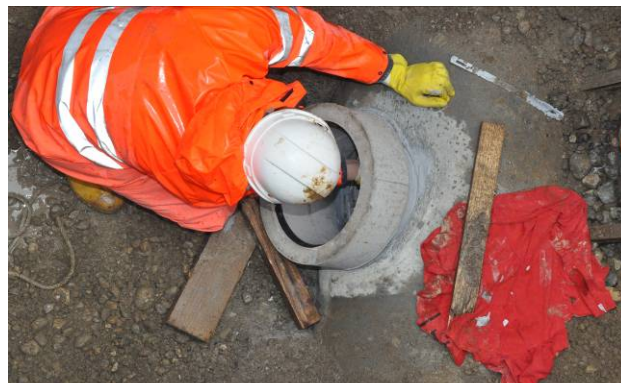
Bild 12: Innenkante von Hand modellieren und Reste entfernen
