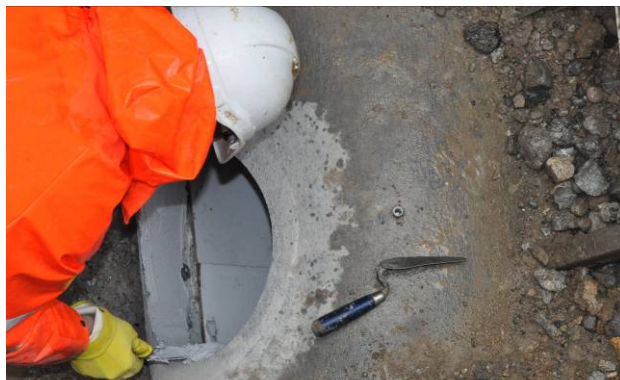
Bild 10: Klebmasse auf die Bohrlochwandung auftragen
