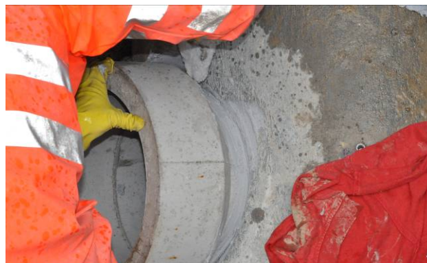
Bild 13: Bilden der äusseren Kehlkannte
