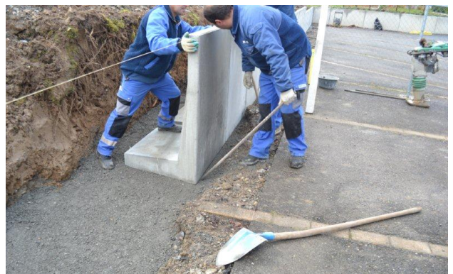
Bild 36: Richten der Winkelplatte
