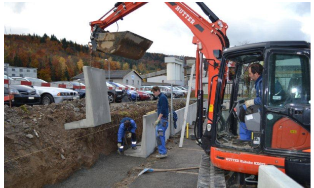
Bild 35: Versetzen der Winkelplatten
