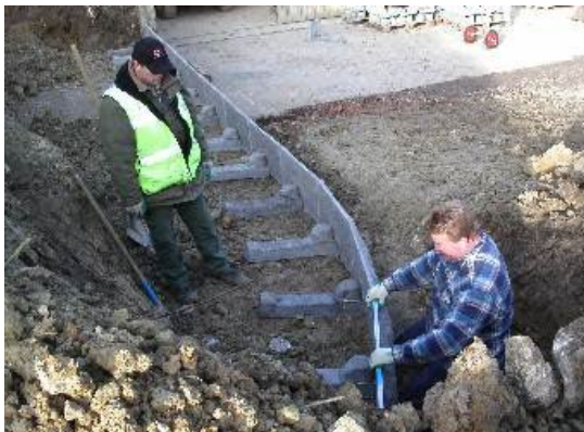
Bild 19: Versetzen der ersten Lage
