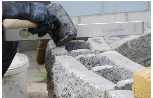
Bild 44: Richten und anklopfen des versetzten Spaltsteines
