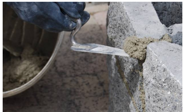
Bild 45: Entfernen von überschüssigem Mörtel
