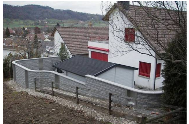
Bild 2: Doppelspaltsteine, eingesetzt als freistehende Mauer
