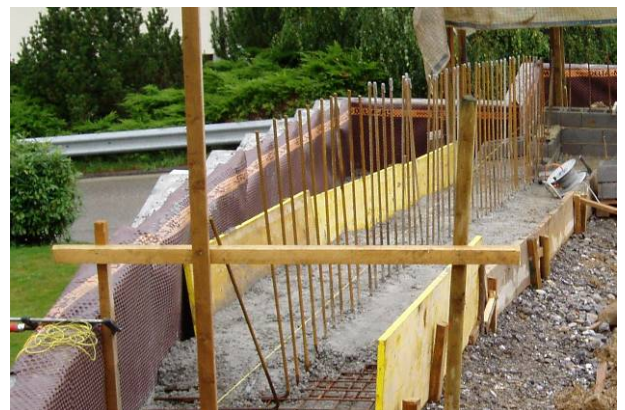
Bild 35: Fundament mit Anschlussbewehrung
