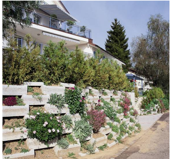
Bild 2: VERDURO® Böschungselemente als Böschungssicherung
