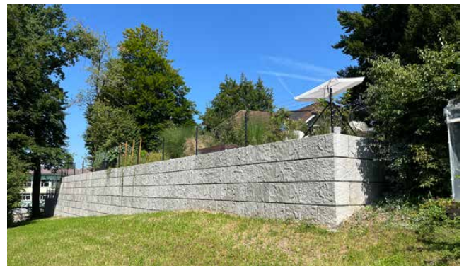
Bild 26 Geländer auf Mauerkrone
