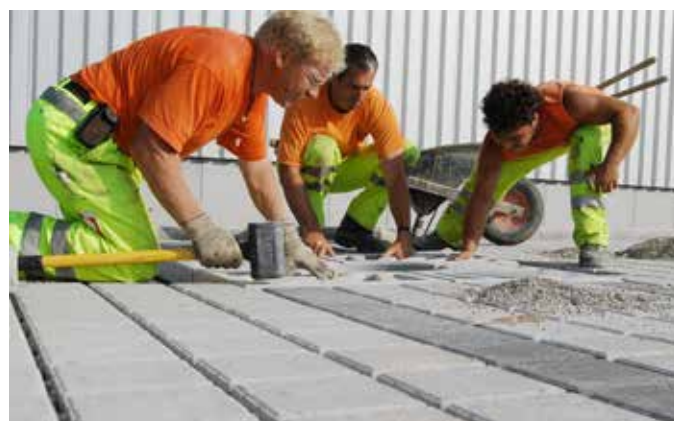
Versetzen der COMO Baumscheiben
