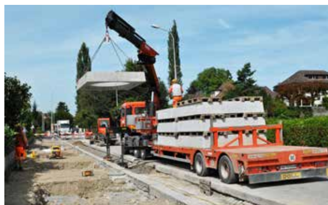
Transport auf der Baustelle mit Lieferfahrzeug
