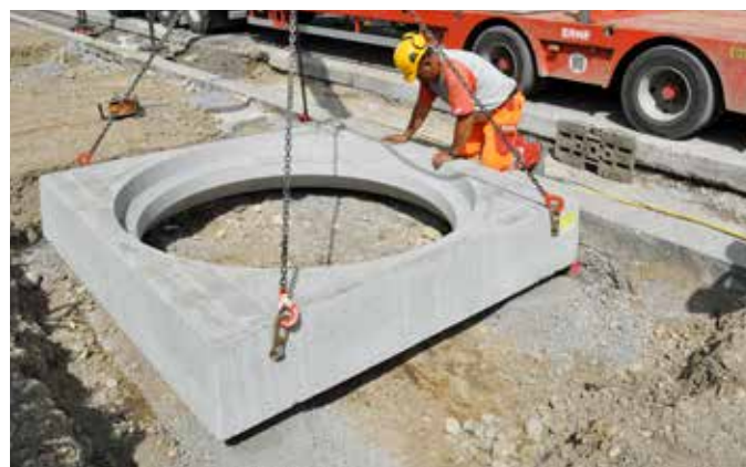
Versetzen des COPAL QUADRO Basiselementes
