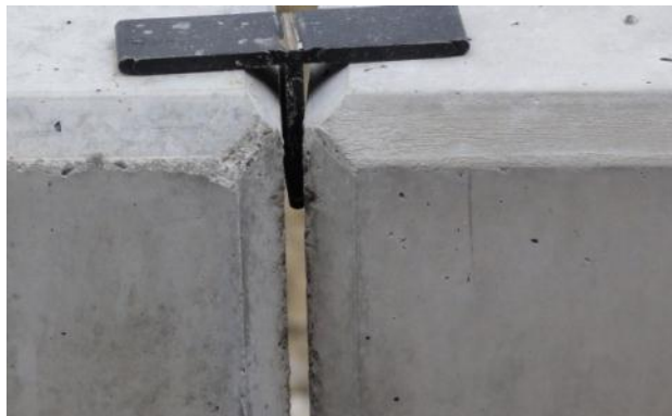
Bild 32: Optimale Fugen nach der Versetzung
