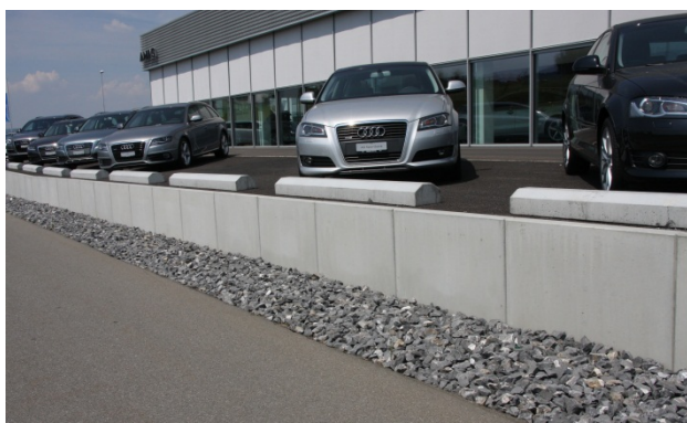
Bild 1: ROZTEC® MIDI Winkelplatten als Böschungssicherung
