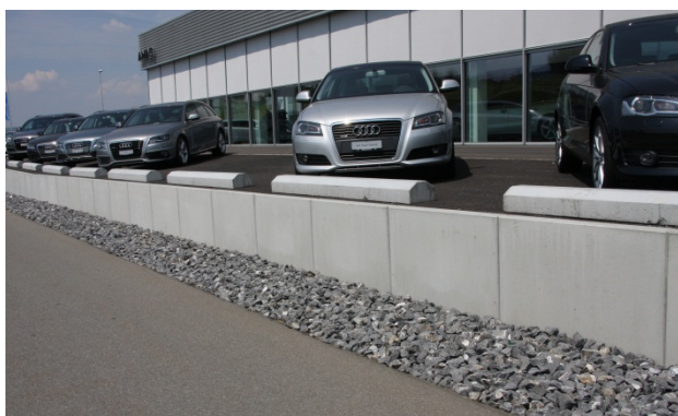
Bild 1: ROZTEC® MIDI Winkelplatten als Böschungssicherung
