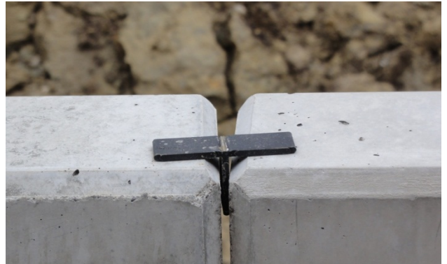
Bild 39: Optimale Fugen nach der Versetzung
