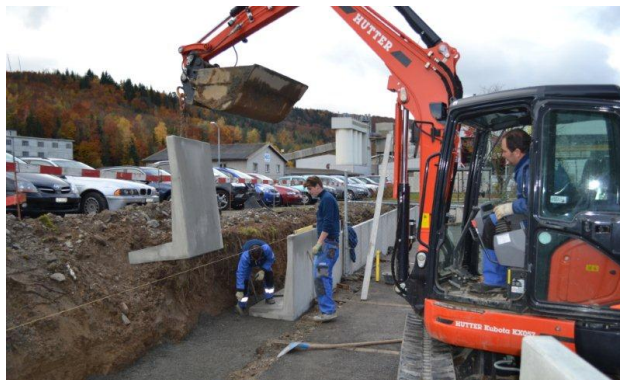
Bild 35: Versetzen der Winkelplatten
