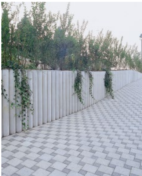
Bild 16: Betonhohlpalisaden als Hangsicherung
