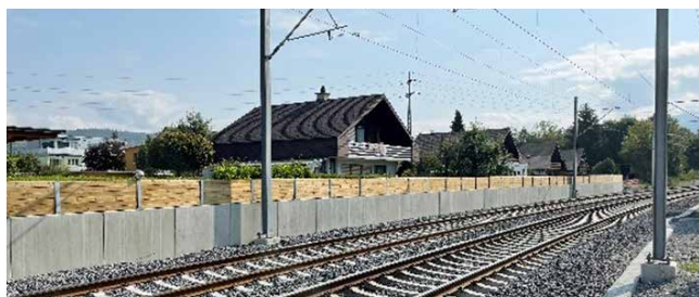
GRANDE Winkelplatten im Bahnbereich
