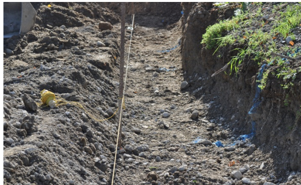
Bild 19: Aushub auf Frosttiefe
