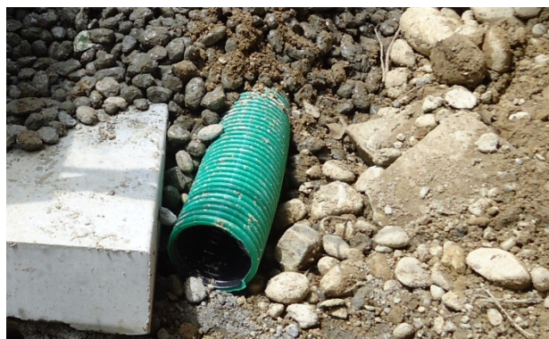
Bild 22: Einbau einer Sickerleitung
