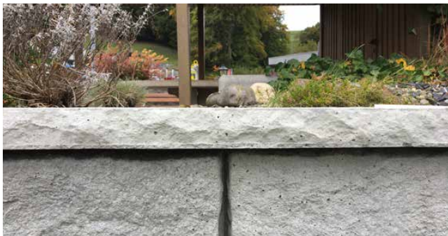
Bild 25 Abdeckplatten versetzt
