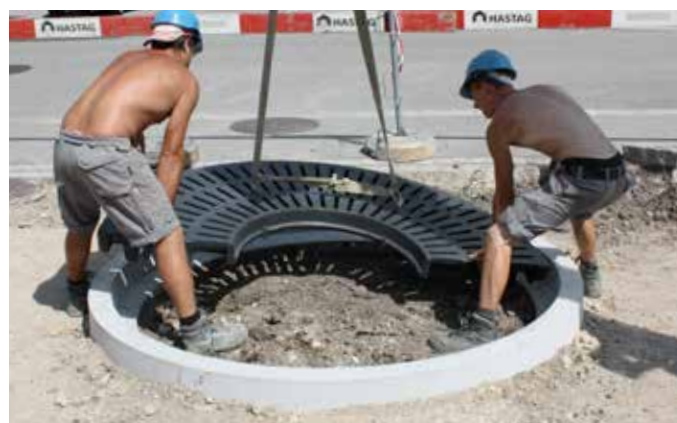
Versetzen der Gussroste
