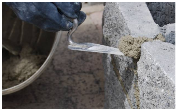
Bild 45: Entfernen von überschüssigem Mörtel
