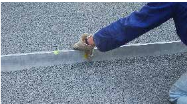
Bild 6: Bettungsschicht abziehen
