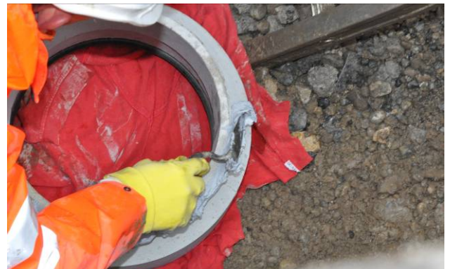
Bild 9: Auftragen der Klebmasse auf den Schaft
