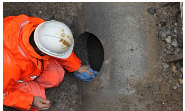
Bild 7: Bohrloch reinigen
