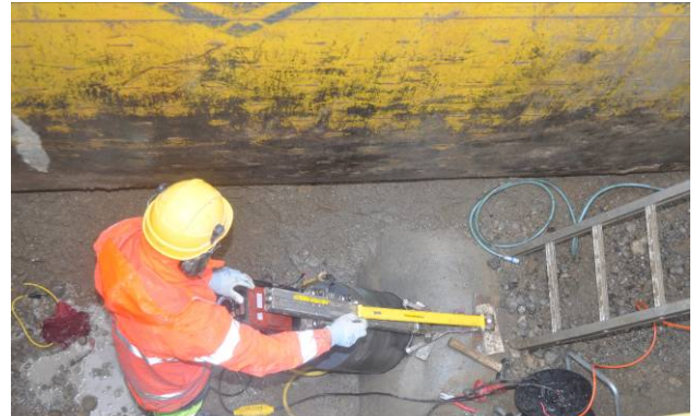
Bild 6: Korrekt montiertes Kernbohrgerät
