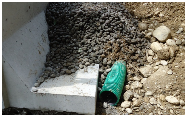
Bild 28: Einbau einer Sickerleitung mit Sickerpackung
