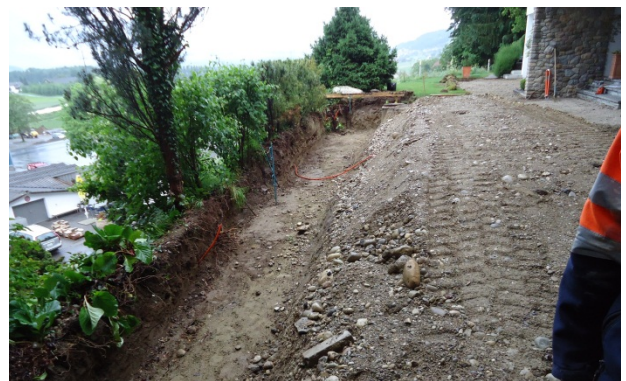
Bild 22: Erstellen der Sauberkeitsschicht
