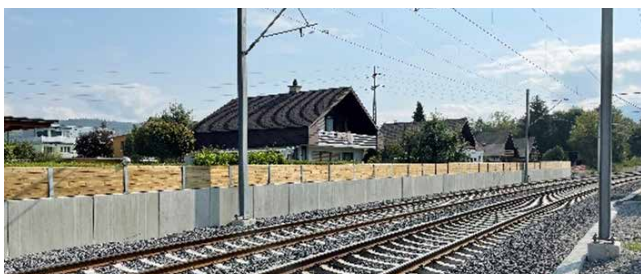
GRANDE Winkelplatten im Bahnbereich
