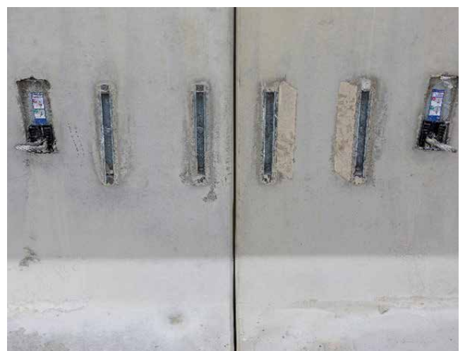
Halfenschienen als Verbindungsgrundlage
