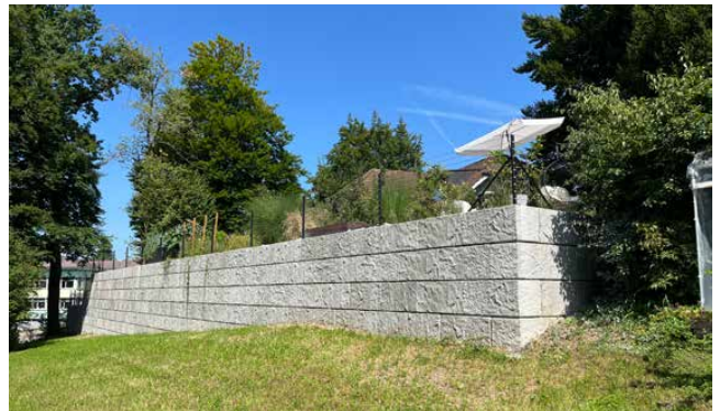
Bild 26 Geländer auf Mauerkrone
