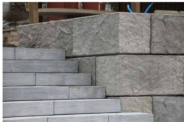
Bild 2 FELSMAUER Böschungselemente als Böschungssicherung
