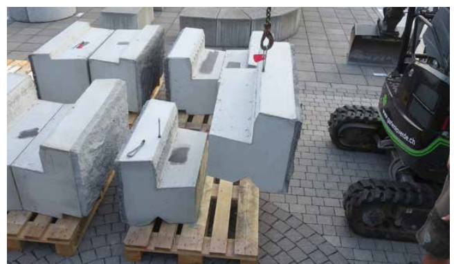
Bild 21 Werkseitig eingebaute Transporthülsen M16
