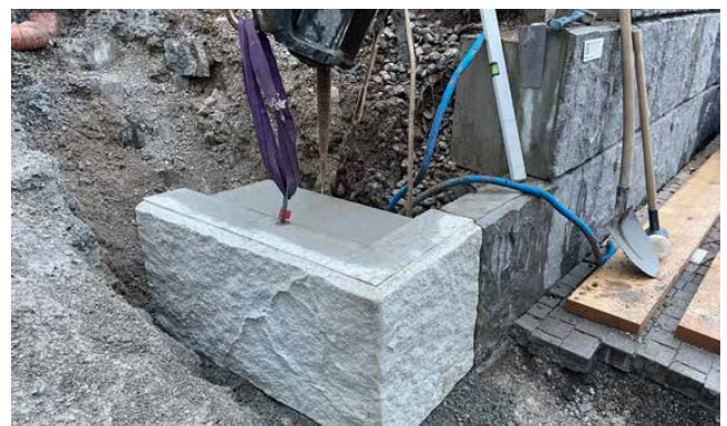
Bild 22 Anfangssteine mit Streifenfundament ohne Klebemörtel
