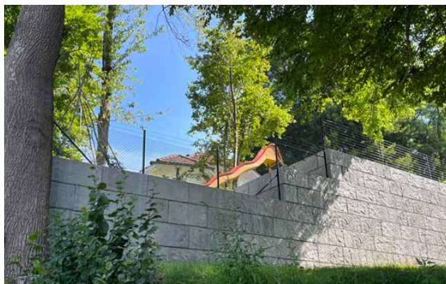
Bild 1 FELSMAUER Böschungselemente als Böschungssicherung
