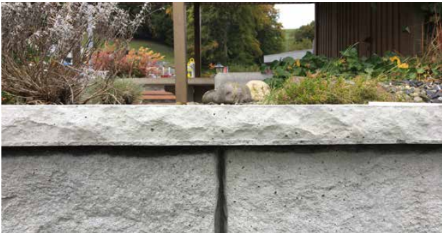
Bild 25 Abdeckplatten versetzt
