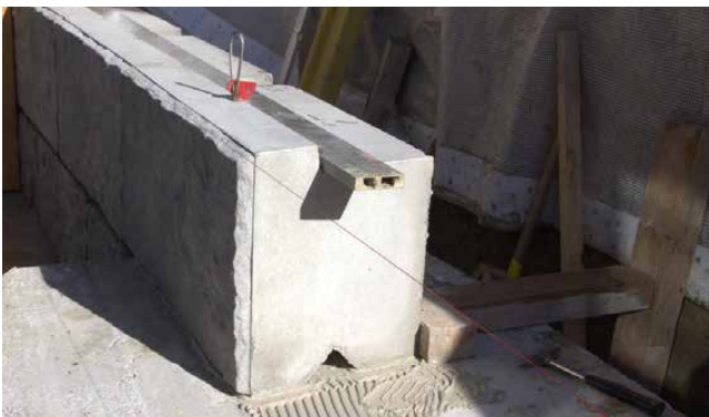
Bild 23 Streifenfundament mit Klebemörteldünnschicht
