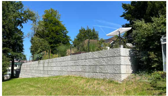
Bild 26 Geländer auf Mauerkrone
