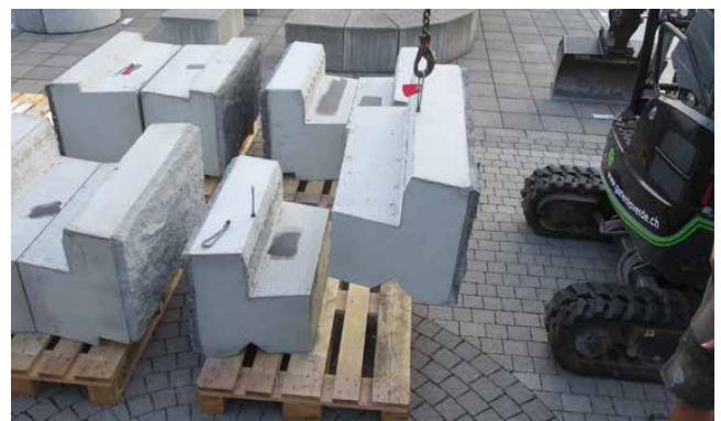
Bild 21 Werkseitig eingebaute Transporthülsen M16
