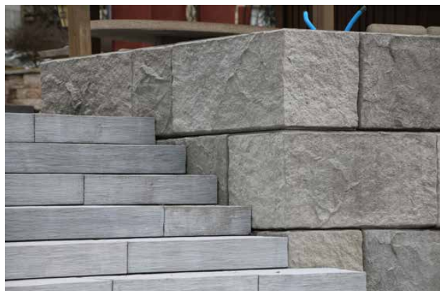
Bild 2 FELSMAUER Böschungselemente als Böschungssicherung
