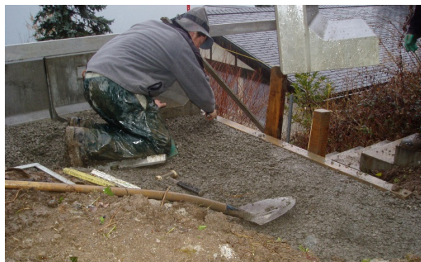
Bild 21: Erstellen des Streifenfundamentes
