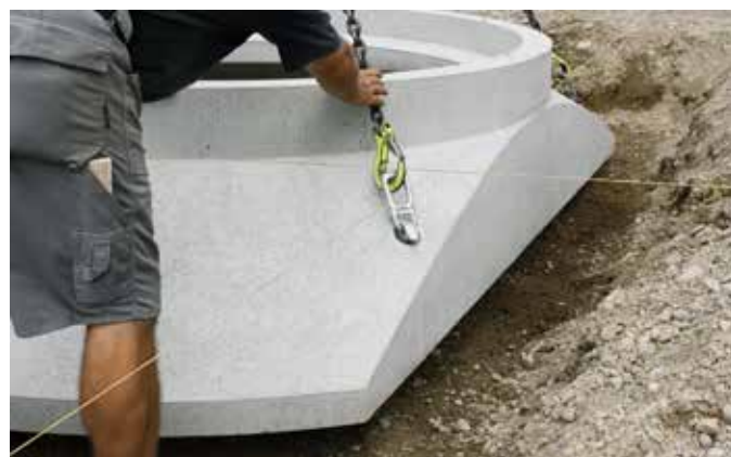
Versetzen des Basiselementes
