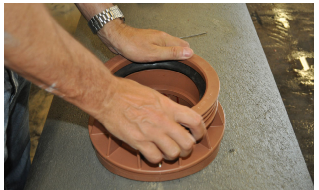
Bild 12: Steckanschlussstück einpressen
