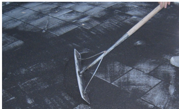
Bild 28: Einbringen des Fugenmaterials von Hand
