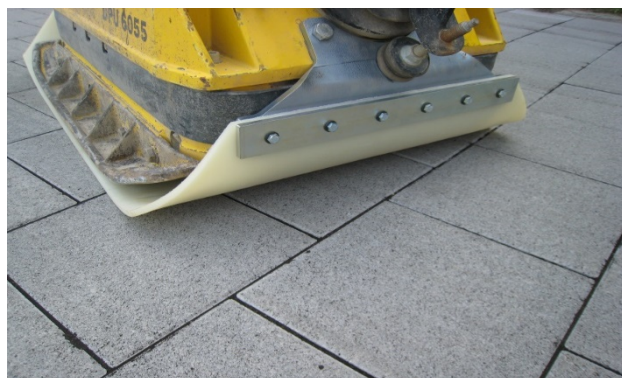
Bild 29: Abrütteln der Pflasterdecke
