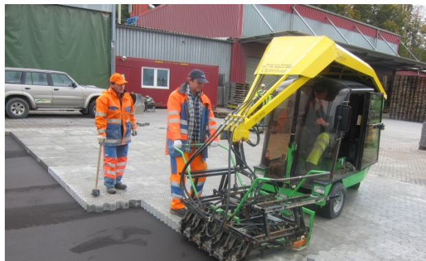
Bild 25: Maschinelle Verlegung
