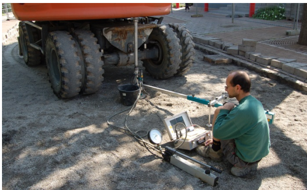
Bild 13: Kontrolle der Tragfähigkeit mit Me-Messungen
