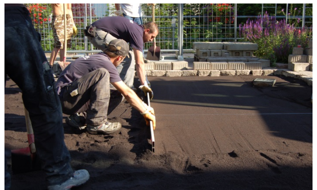
Bild 18: Mischgut abziehen
