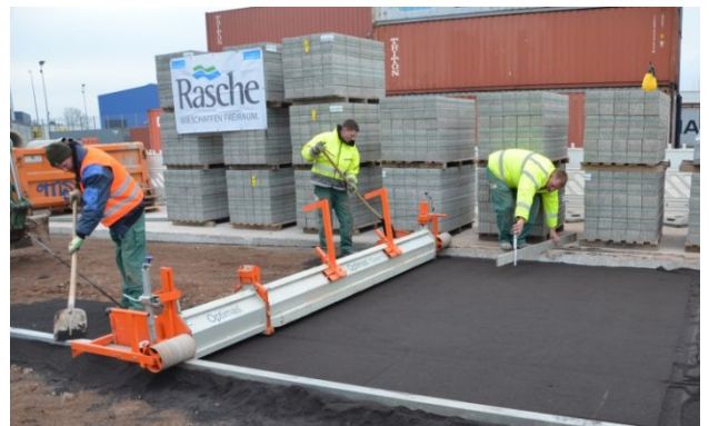
Bild 19: Mischgut abziehen
