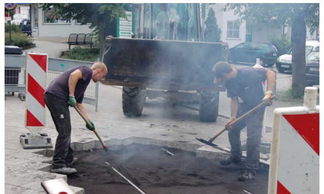
Bild 17: Mischgut muss gesetzt werden
