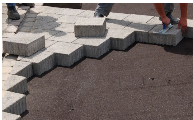
Bild 26: Verlegen von Hand
