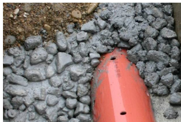
Bild 33: Eingebaute Sickerleitung
