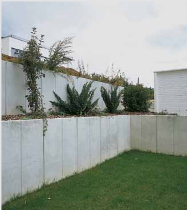
Winkelplatten als Hangsicherung
