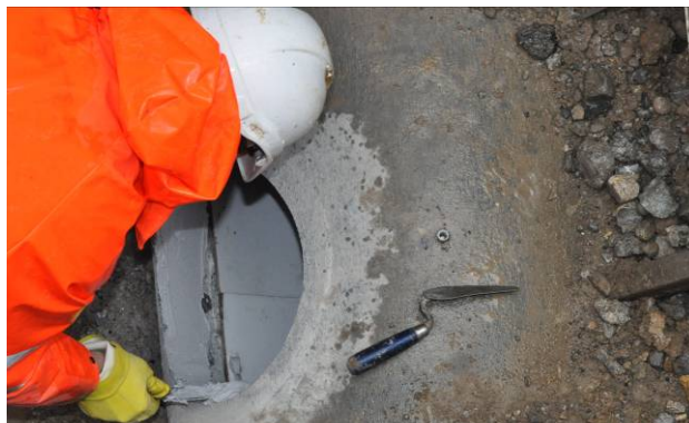
Bild 10: Klebmasse auf die Bohrlochwandung auftragen
