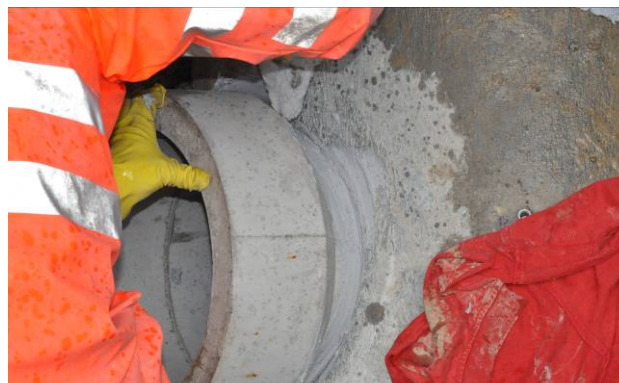
Bild 13: Bilden der äusseren Kehlkannte
