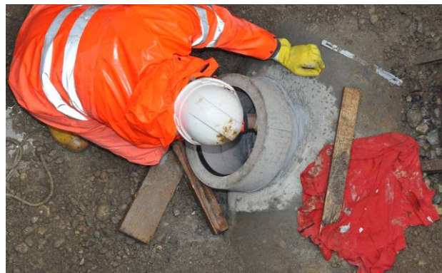
Bild 12: Innenkante von Hand modellieren und Reste entfernen
