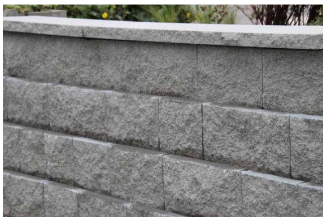
Bild 1: Geschlossener Aufbau mit Abdeckplatten
