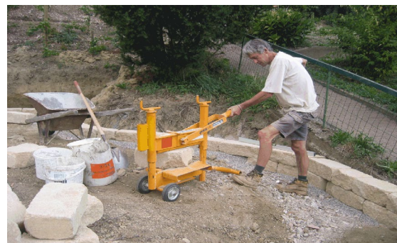
Bild 35: Arbeiten mit Steinspalter
