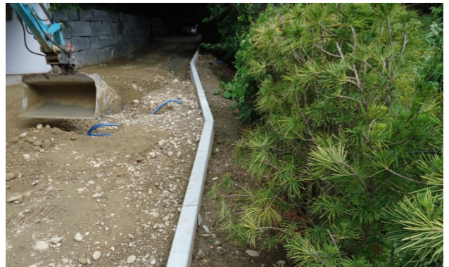
Bild 41: Lagenweises Einbringen von geeigneten Hinterfüllmaterial
