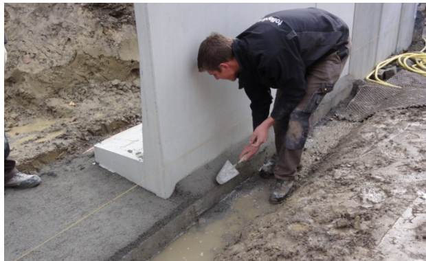
Bild 37: Erstellen der Fundamentnocken
