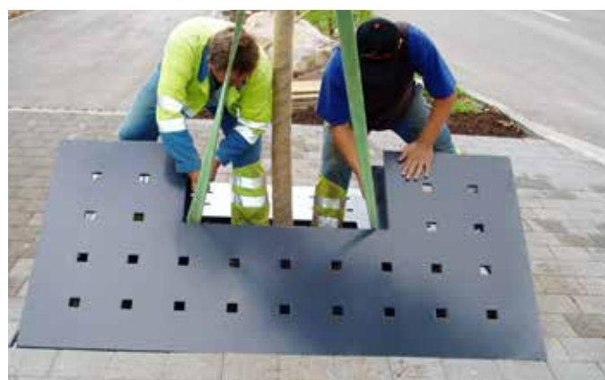
Versetzen der COPAL STEEL Stahlbaumscheibe
