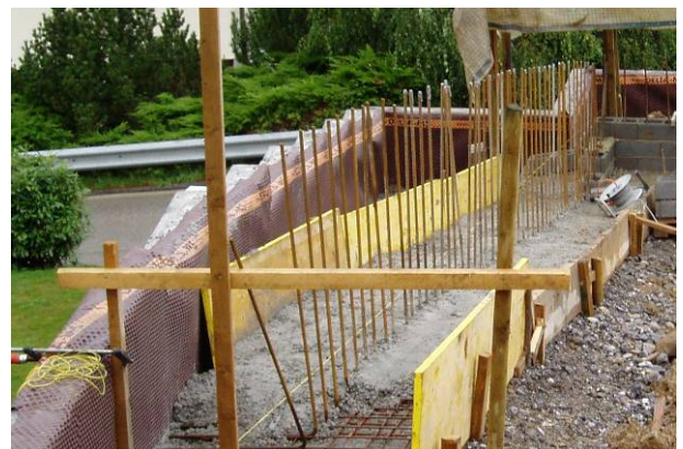
Bild 35: Fundament mit Anschlussbewehrung
