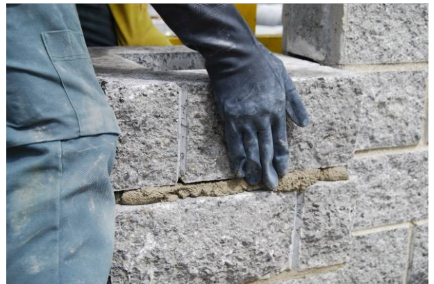
Bild 59: Versetzen von Pfeilerspaltsteinen
