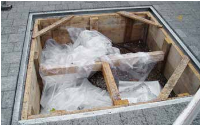
Eingebauter Stahlrahmen als Baumkranz
