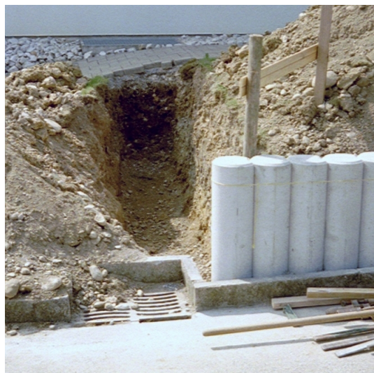
Bild 8: Aushub für Streifenfundament
