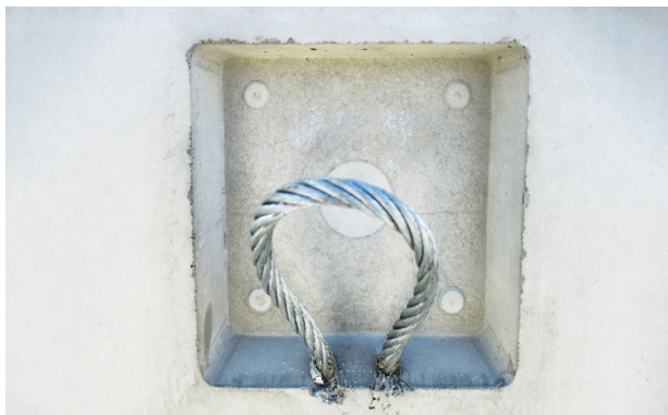
Bild 24: Werkseitig eingebaute Versetzschaufen
