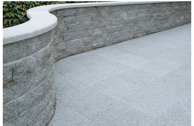
Bild 3: Mauer mit Radiusspaltsteinen
